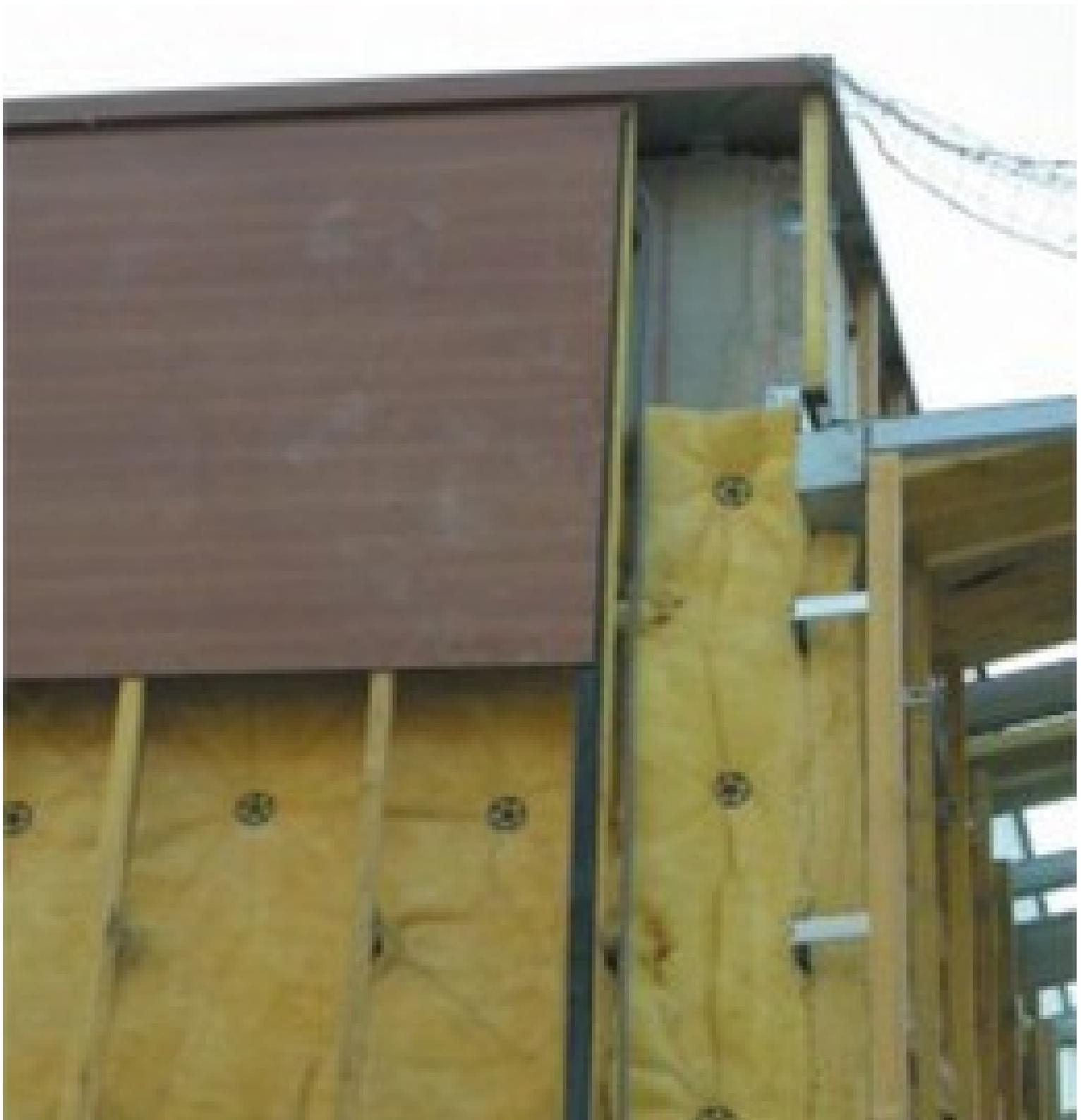
L'isolation thermique par l'extérieur consiste à envelopper le bâtiment d'un manteau isolant. Dans l'existant, une isolation par l'extérieur peut être envisagée lors d'une rénovation complète ou un ravalement de façade, après avoir consulté les règles d'urbanisme de la commune.
